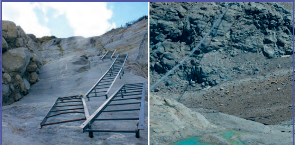
Figure 21. Conserver l'accessibilité des refuges de haute montagne grâce à la mise en place d'équipements : un travail d'aménagement délicat. À gauche : les 90 mètres d'échelles reliant le train du Montenvers à la Mer de Glace (photo : J. Mourey) ; à droite : la passerelle de 190 mètres de long au-dessus du front du glacier de Corbassière (Valais, Suisse) permettant d'accéder à la cabane de Panossière (2641 m ; photo : J.-L. Pitteloud).
